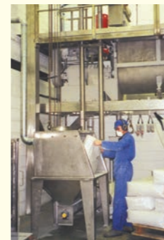
Vertido manual de bolsas en mezcladora usando una transportador vertical y un tornillo alimentador integral.
